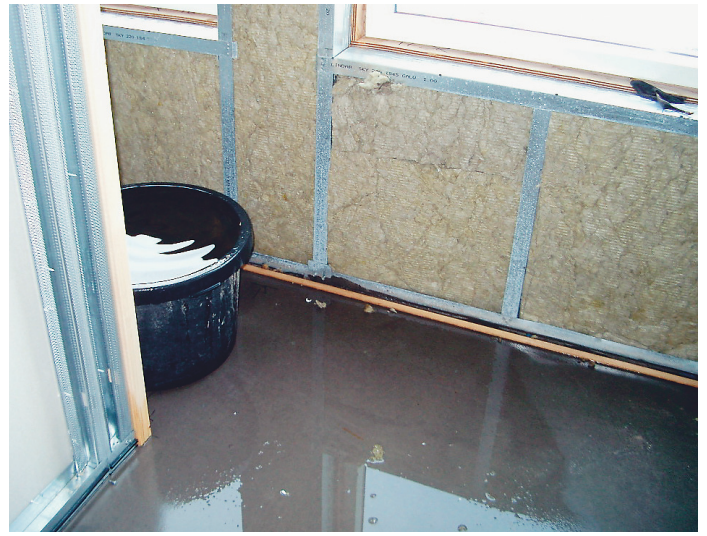
... inläckage av vatten från tak...
