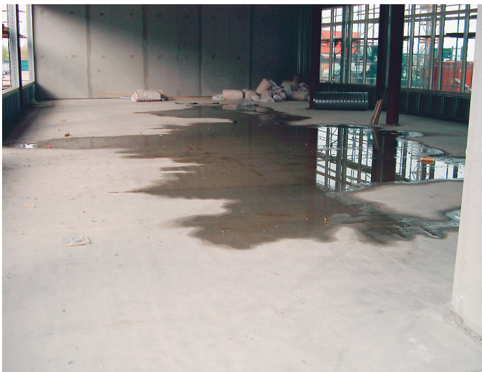
Exempel på fuktproblem: Vatten på betong...
