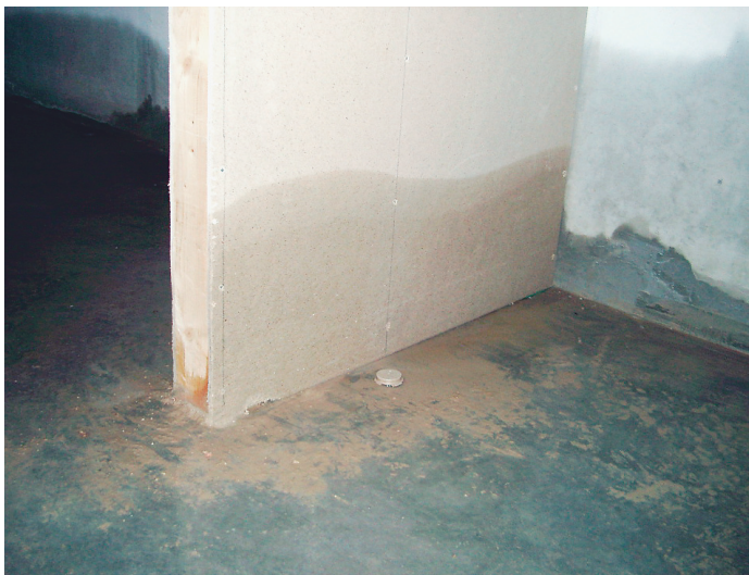
... uppsugning av vatten i gipsvägg.
