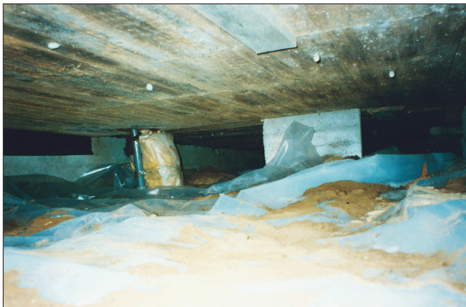
Kraftig mögellukt från mögelpåväxt på blindbotten, på sågspån ovanpå plastfolien samt skräp och byggrester under folien.
