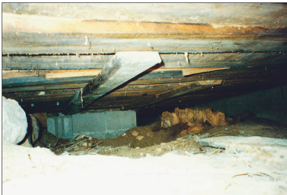
Rötskador i gammal torpargrund där man slutat elda i skorstenen.
