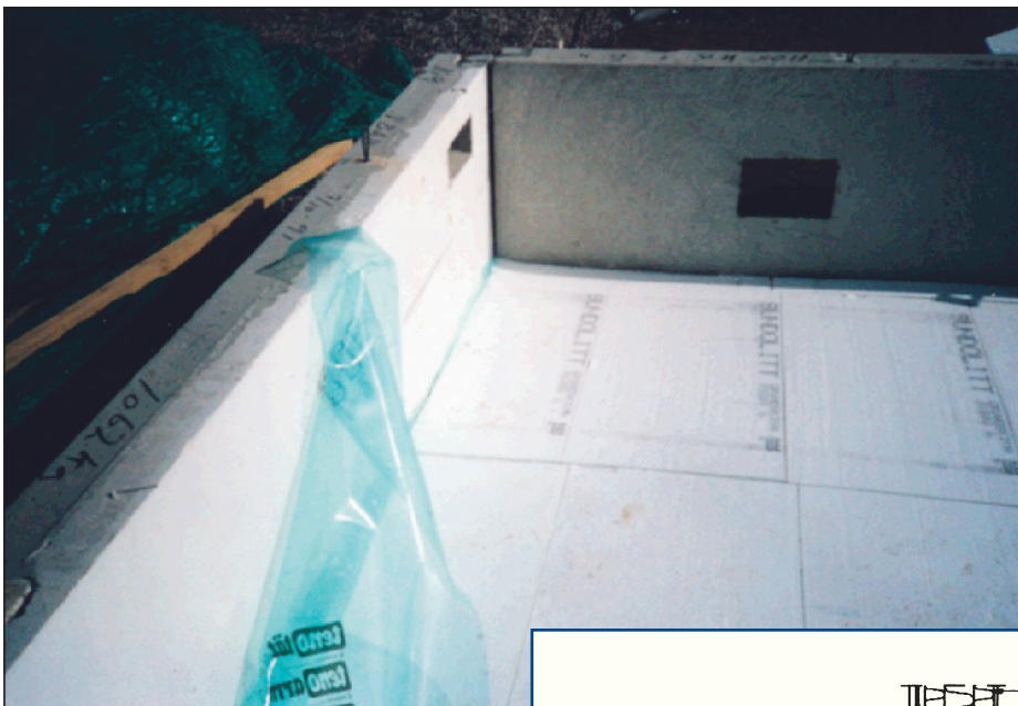
Modifierad uteluftsventilerad krypgrund från Bo92 under uppförande.
