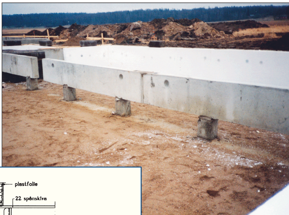
Inneluftsventilerad krypgrund från Bo92 under uppförande. Markisoleringen är ännu inte utlagd.
