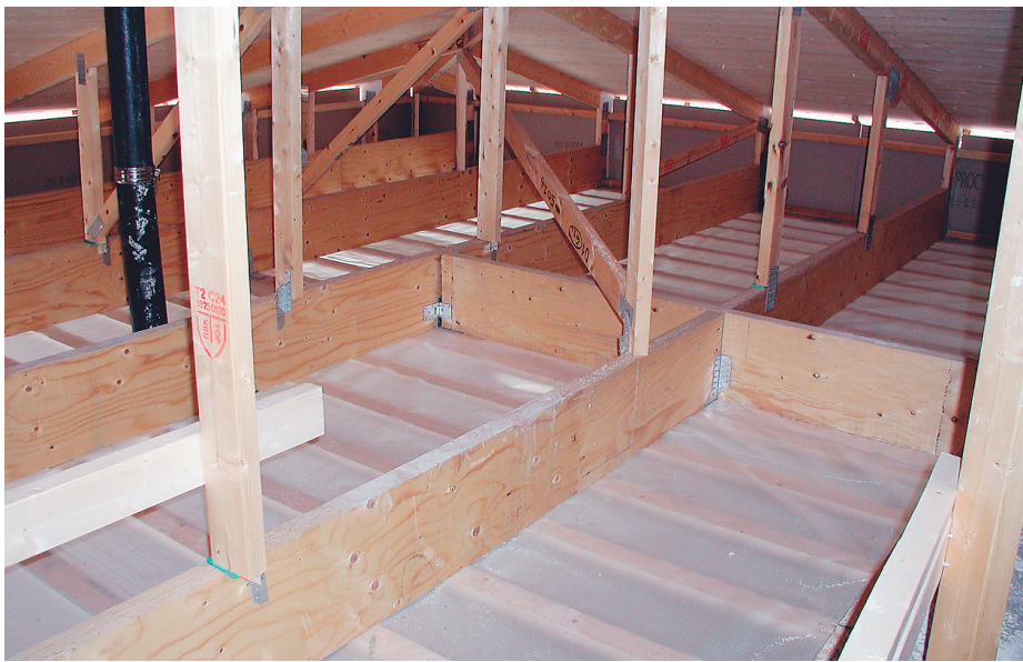
Bild 1. Vindsutrymmet i hus 4 före utläggning av lösullsisolering.
