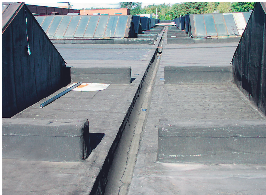
Många detaljer i ett äldre tak har täckts in med nytt tätskikt av Derbigum.
