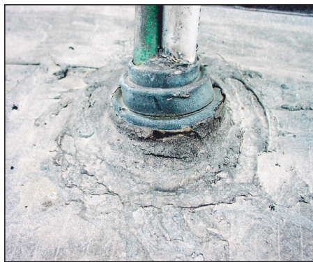
Spricka i utflyt vid en el-genomföring.
