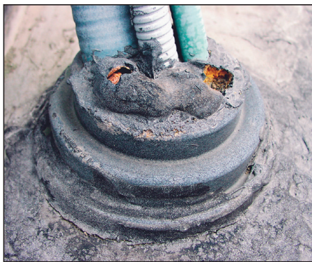
Tveksam anslutning mot el-genomföring. Detaljen är inte utförd i samband med läggningen av taket.
