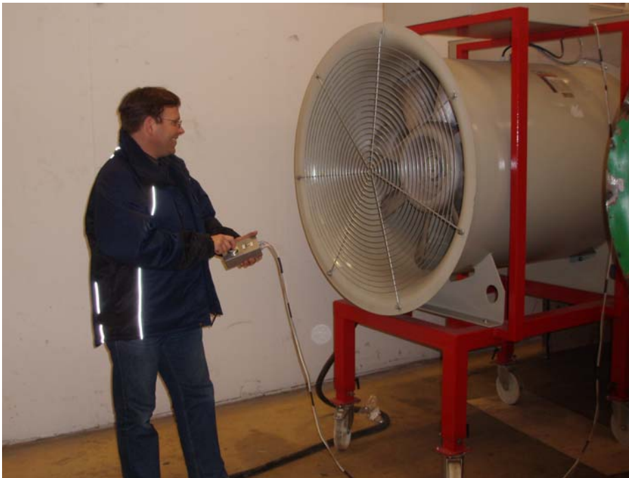
Figur 4.3 Täthetsprovning med en stor fläkt vars kapacitet klarar stora byggnader såsom industrihallar, kontorsbyggnader mm.
