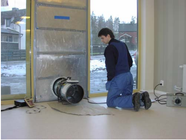
Figur 4.2 Täthetsprovning med en fläkt som monterats i en dörröppning. En mindre fläkt av denna typ används oftast vid täthetsprovningar av mindre byggnader eller vid provning av en begränsad del av en stor byggnad.
