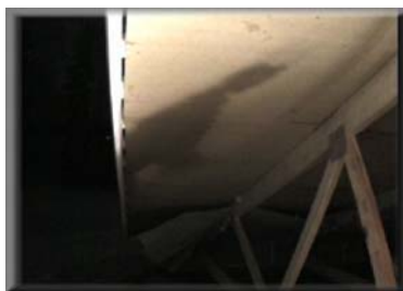
Figur 4.15 En mörk fuktfläck på undersidan av underlagstaket
