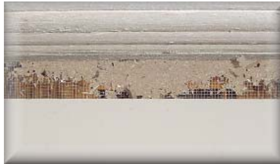
Figur 6.10 Större partiklar stoppas effektivt upp av insektsnätet
