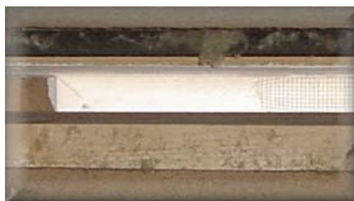
Figur 4.13 Ett stort glapp i insektsnätet hittades
