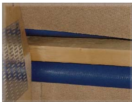
Figur 4.5 Den täta nockfolien på Kvarnsjötorp
