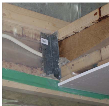
Mellanbjälklag infäst med balksko mot yttervägg
