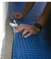
Foto 2, Läggningskontroll av distansmatta
