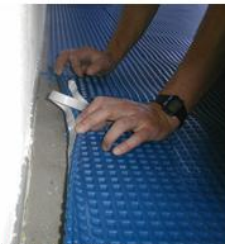
Foto 2, Läggningsskontroll av distansmatta
