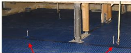
Foto 1, Exempel på utförande med montagebultar i ett distansgolv inför gjutning.
