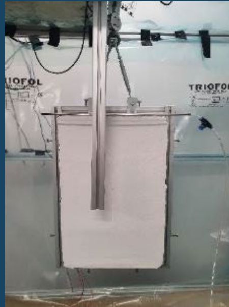
Skadad vägg (horisontell spricka)
