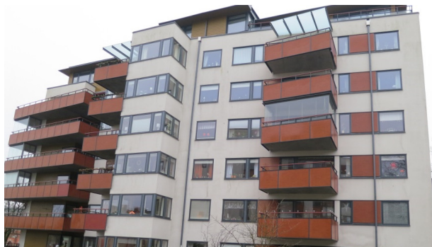
Fasad åt söder
