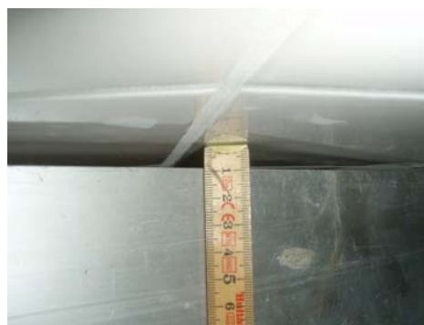
Buktning i våtrumsvägg
