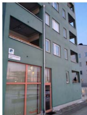
Passivhus (i samma område) byggt 2008 där man jobbat hårt med att få bort alla köldbryggor. Man kan på vissa ställen se infästningarna för putsalken om man tittar noga och en liten, liten antydning vid bjälklagskanten. Bjälklagskanten och lägenhetsskivande väggar var hela 19% av väggarean (fönster borträknat). Det resulterade att man valde extra isolerade bjälklagskanten och tjockare putsalka. Som minst är det 14cm isolering på bjälklagskanten. Jag gissar att det är mer än 10cm mer än de andra husen på denna bild har.
