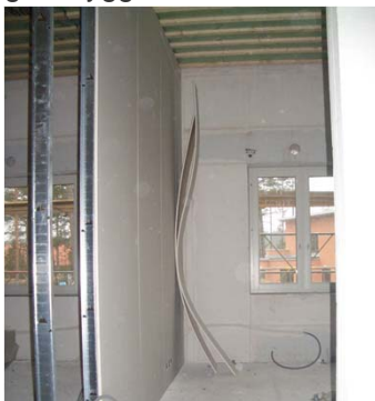
Torkning av byggfukt.....
