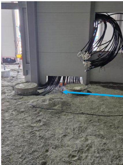
Värmekablar i mark, pågående byggnation Foto: Pär Lundberg, AB Byggtest
