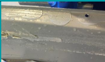
Punktvis med fogmassa på fönsterbleckets bakkant.
