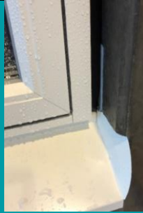
Sekundär tätning synlig bakom fogband.
