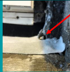
Hål till insidan under sekundär tätning vid det högra hörnet. Sannolikt primär orsak till inläckage.
