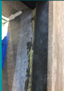
Punktvis med fogmassa på fönsterbleckets bakkant.
