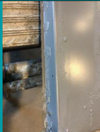
Punktvis med fogmassa på fönsterbleckets bakkant.
