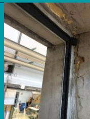
Yttre fogband i fönsteröppning.
