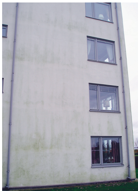
Bild 5: Fasad med påväxt av alger.
