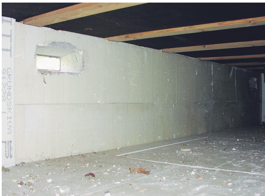
Figur 1: Insidan av den uteluftsventilerade grunden på Bo92-området. Grunden har värmeisolering av cellplast på ovsidan av marken och på insidan av grundmurar. Blindbotten utgörs av asfaboard. Prover har tagits i grunden för mikrobiologisk analys.
