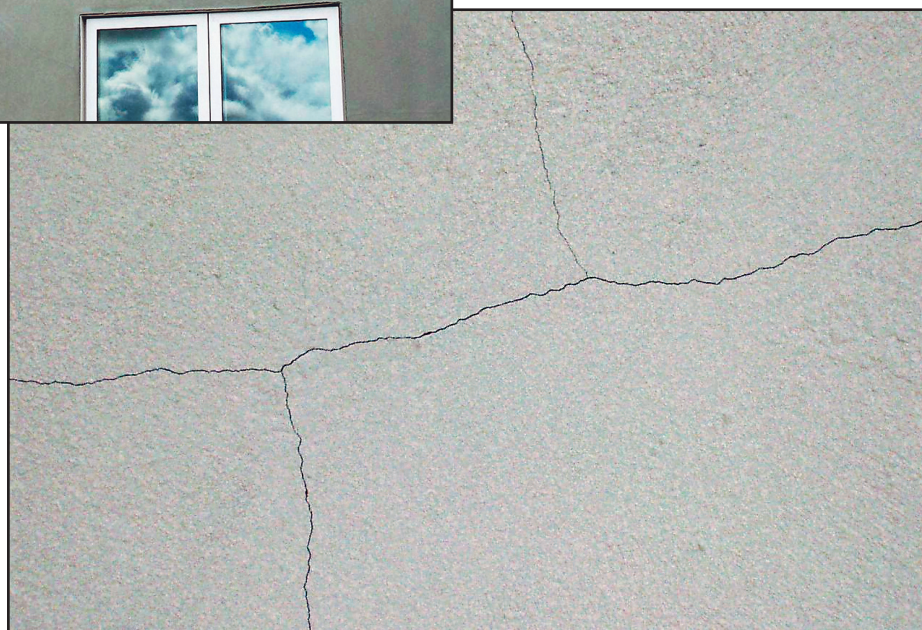
Sprickor i putsad fasad.
