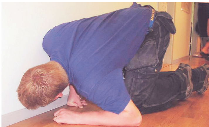
Mögellukt i golvvinkeln är ofta ett tecken på fukt- och mögelskada inuti byggnadskonstruktionen.
