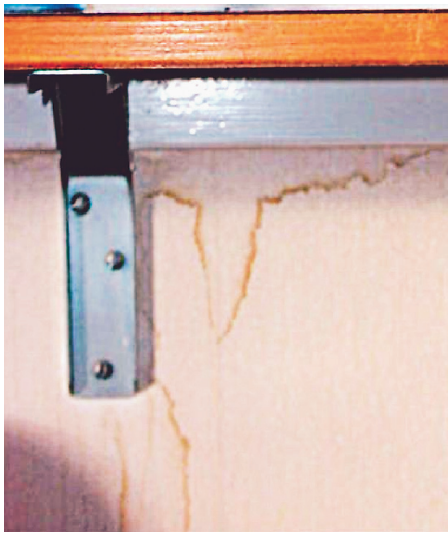
Synlig fuktfläck missfärgning är inget säkert tecken på en hälsorelevant fuktskada.
