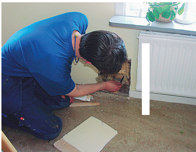
Thorbjörn Gustavsson, SP, undersöker en fukt-skada i en yttervägg.
