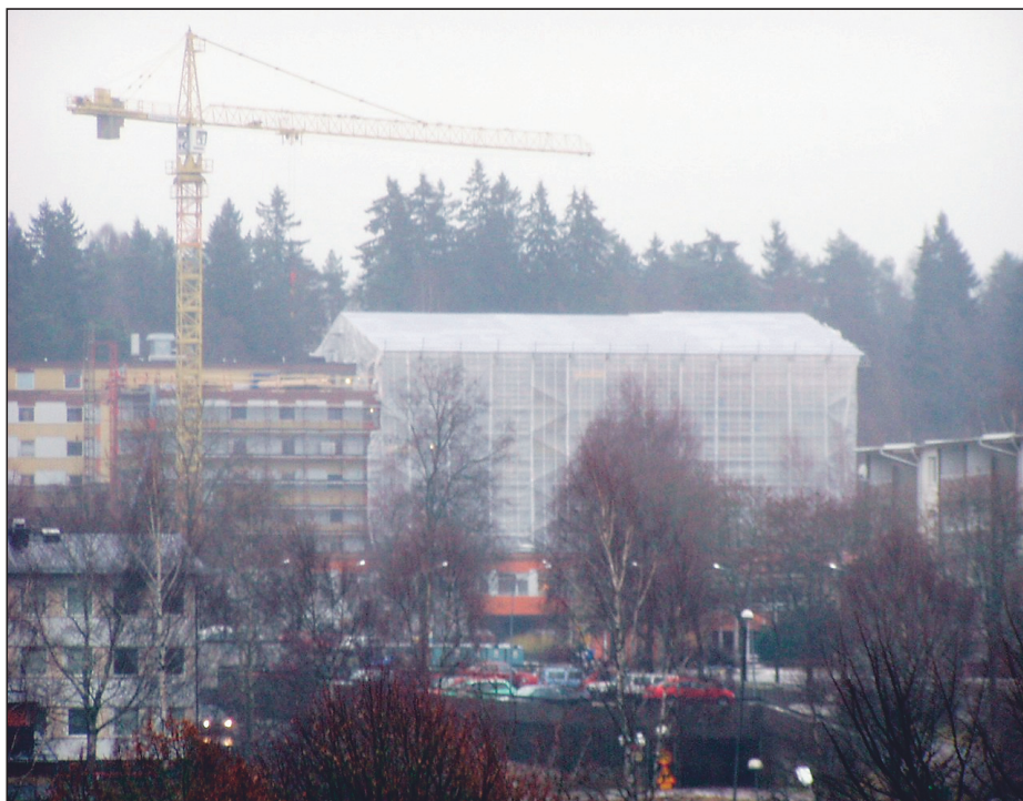
Väderskyddat byggande eller inte är ett av många överväganden som byggherrar och byggprocessens aktörer ställs inför under byggprocessen. Här en ombyggnad av ett äldreboende i ett disigt Borås där väderskyddat byggande använts med framgång.
