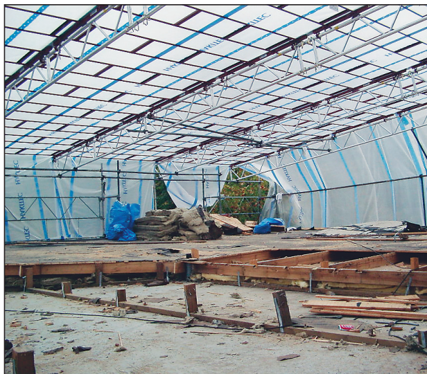
Ett tak har frilagts inför en ombyggnad. Detta är ett känsligt moment i ombyggnadsprocessen. Därför har byggherre och entreprenör valt att skydda byggnaden med ett väderskydd.
