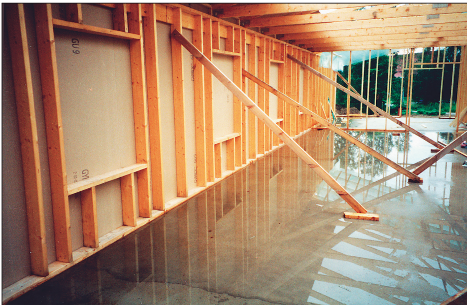
Stor risk för fuktskador i väggar om träreglar och syllar inte skyddas under byggskedet.
