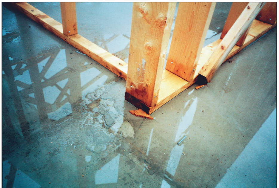
Det är vanligt att innerväggssyllar ligger direkt mot betongen utan fuktspärr. Om det är så här blött under byggskedet (vilket det ofta är) kommer både syll och stående reglar att bli blöta och få påväxt av mikroorganismer. Detta kan komma att leda till framtida innemiljöproblem i byggnaden.
