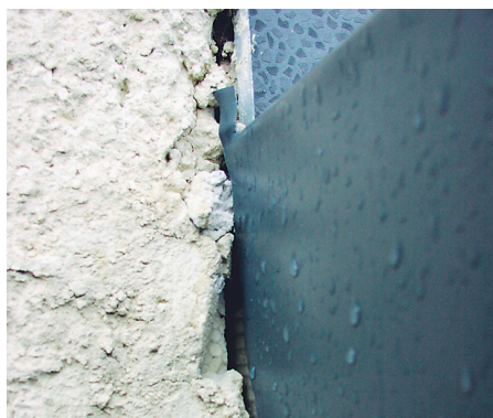
Bild 10. Otätheter vid skärmtaksinfästning.
