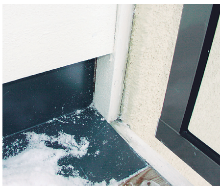
Bild 9: Otätheter vid sidoanslutning till balkong.
