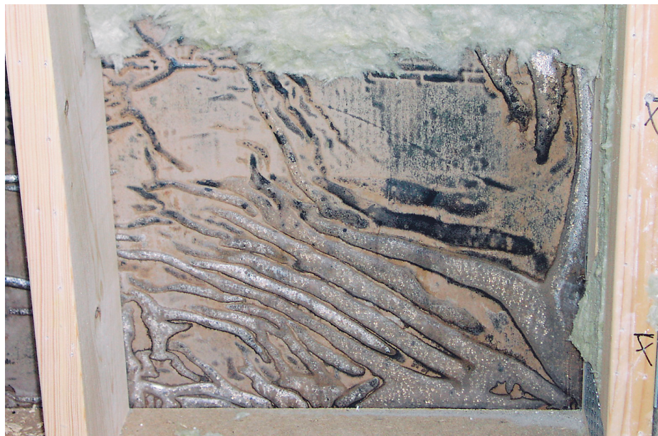
Bild 1: Fuktskadad gipsskiva mellan tätskikt och plastfolie.
