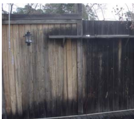
Figur 7. Mögelbeväxning på plank.
