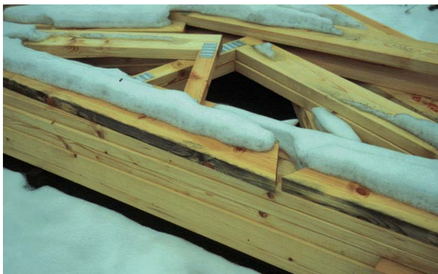
Figur 31. Olämplig förvaring av virke.
