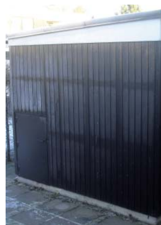
Figur 18. Frost på träfasad.
