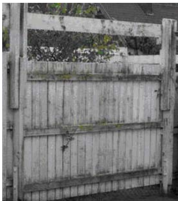
Figur 13. Alger på plank.
