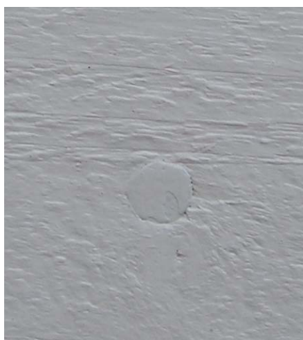
Figur 34. Spikskallen skall ligga i nivå med träytan.
