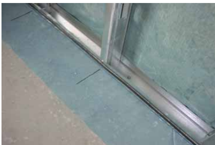
Bild 19 Anslutning av väggens PE-folie genom klämning av plåtregel och tätremsa (gummiflansar) mot betong.
