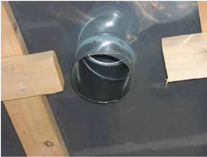
Bild 12 Genomföring av kanal där håltagning är utförd något mindre än kanalen.
