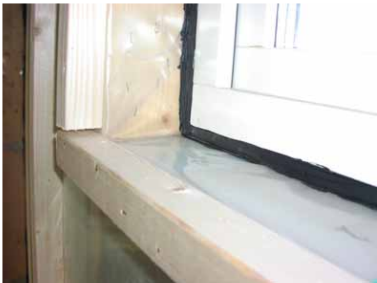
Bild 3 Anslutning vid fönster där PE-folien vikts in i smygen. En kompletterande PE-folie har häftats fast i hörn.
