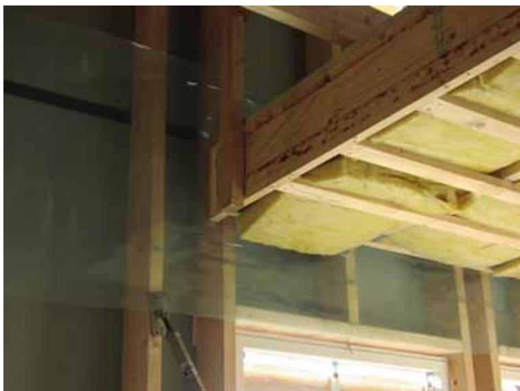
Bild 7 Prefabricerade bjälklagslement har förberetts med en PE-folie som skall anslutas mot PE-folie i vägg. På detta sätt blir PE-folien dragen hel förbi bjälklagsanslutningen som annars är en svårlöst detalj.
