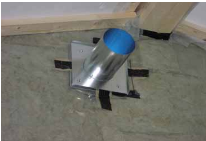
Bild 22 Genomföring av kanal i tätskikt med hjälp av en specialtillverkade flänsar där PE-folien och butylgummiband kläms genom att flänsarna skruvas ihop.
