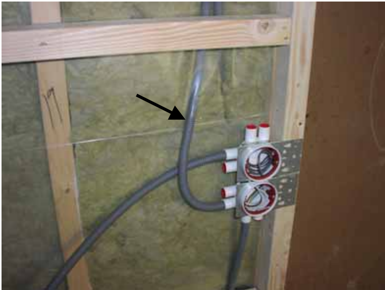
Bild 6 Eldragningar är planerade att finna invändigt PE-folien. I detta fall har dock eldragningen dragits genom PE-folien för el-dragning till utebelysning.
