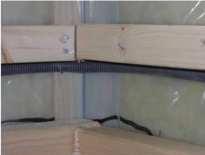
Bild 17 Överlapp i vägghörn med endast några 10-tal mm.
