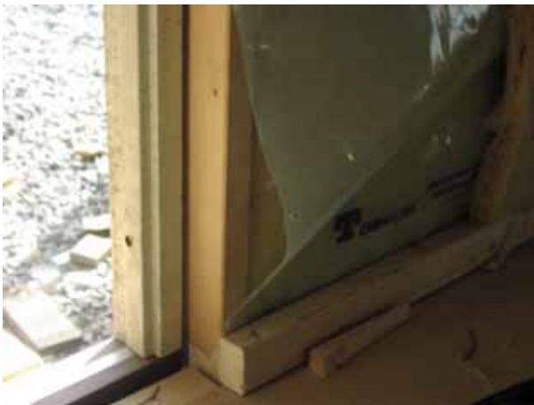
Figur 3.13 En bubbla har bildats vid monteringen av plastfolien. En sådan bubbla skapar sämre förutsättningar för lufttätning.
