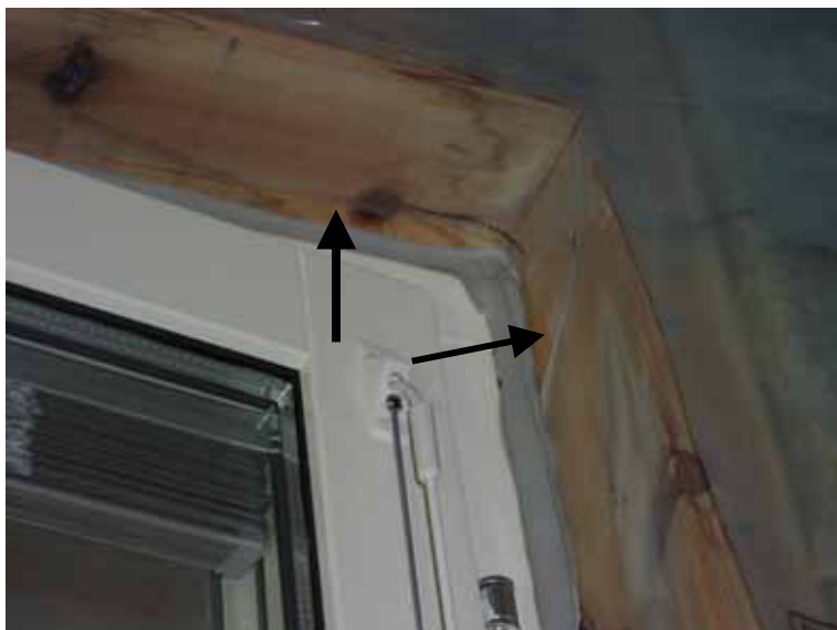
Bild 2 Fönsteranslutning där plastfolien viks in i fönstersmyg. Plastfolien tätas sedan men fogmassa mot fönsterkarm. Glipor mellan plastfolie och fog förekommer dock. Se pil.
