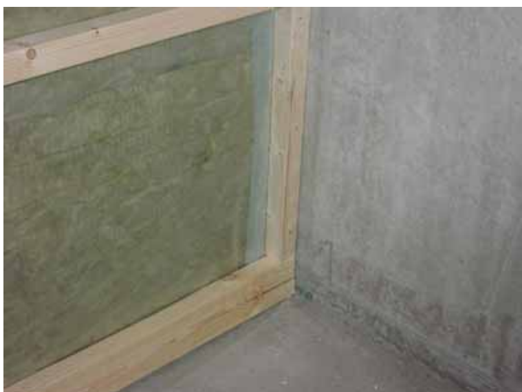
Bild 4 Anslutning av utfackningsvägg mot betongstomme. S-list finns klämd mellan syll och väggregel och betong. PE-folien är klämd med träreger mot plåtregel.
