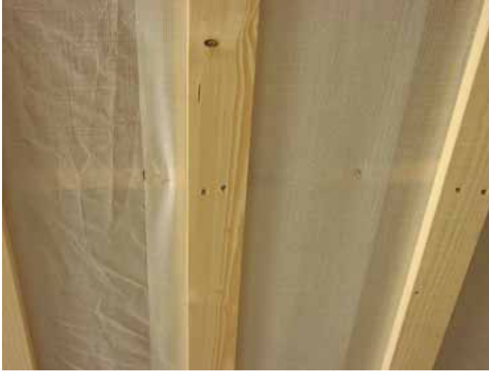
Bild 16 Överlapp mellan säkerhetsfolier i tak är här utförd över 1 glespanel och med klämning med isolering.
