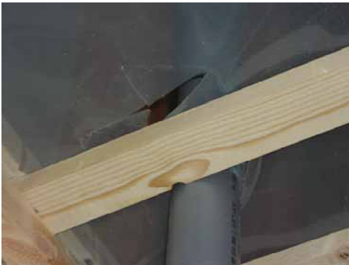
Bild 13 Genomföring av kanal där håltagning är utförd större än kanalen och luftläckage kan ske.
