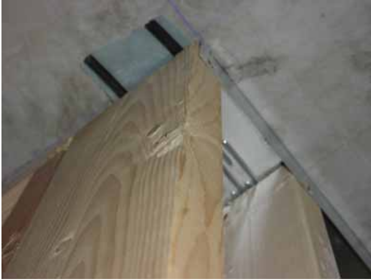
Bild 5 Tätremsa av S-list mellan hammarband och betongbjälklag.
