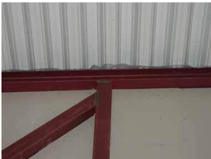
Bild 23 PE-folie från tak och vägg förs in för klämning mellan stål balk och tak. Oklars hur tät sådan lösning blir.
