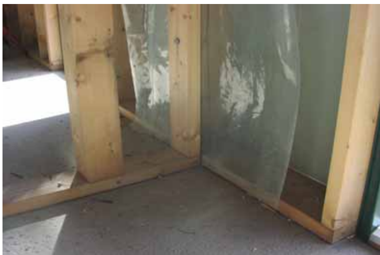
Bild 8 Även prefabricerade mellanväggar har förberetts med PE-folie för anslutning mot PE-folie i vägg.
