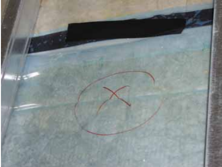
Bild 20 Fog mellan två e-folier i vägg med dubbelhäftande butylgummiband. Den dagliga kontrollen har här medfört en markering (rött x) som innebär att åtgärd skall genomföras.
