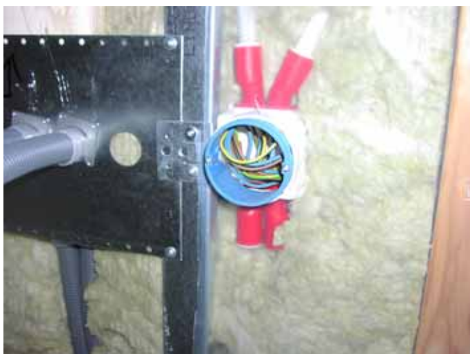
Bild 1 Genomföring av värmerör och eldosor.
