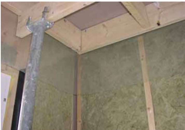
Bild 21 Prefabricerat mellanbjälklag har förberetts för avslutning mot vägg med en PE-folie som skall ansluta mot väggens PE-folie med butylgummiband.
