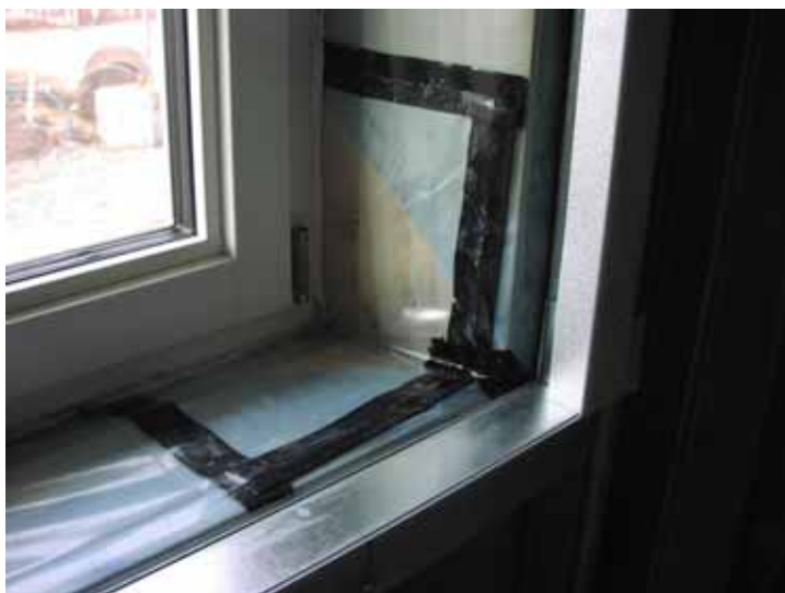
Bild 18 Anslutning vid fönster med bl a butylgummiband.
