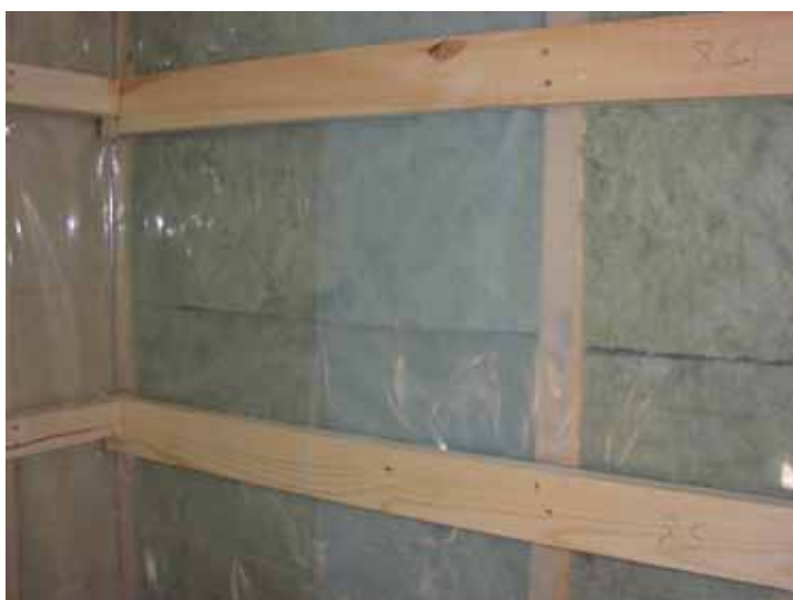
Bild 11 Skarv i vägg genom att två PE-folier överlappar varandra.
