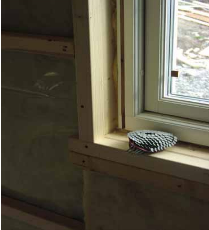
Bild 14 Fönsteranslutning där PE-folien skurits av vid väggregel runt fönster och klämning sker mellan två träreglar.
