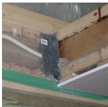
Mellanbjälklag infäst med balksko mot yttervägg
