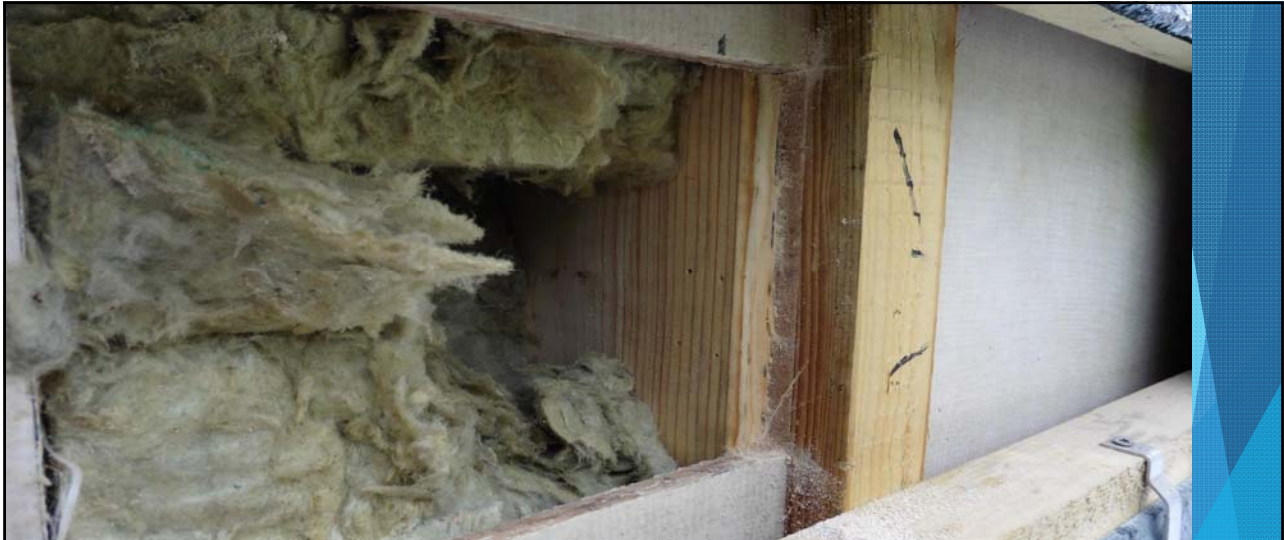
Stolpe bag vindspærren opfugtet ca. 5 cm ind i konstruktionen
