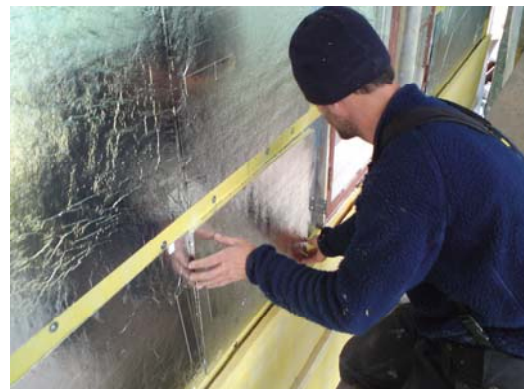
Bild2 Montage av vakuumisolering i Göteborg.
