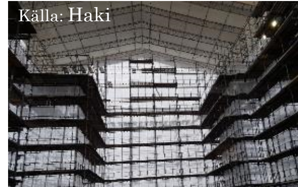
B. Fristående ställning som byggs till fullhöjd med fast tak
