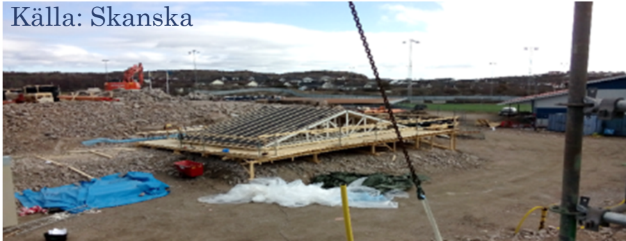
A. Provisorisk takkassett på varje dag
