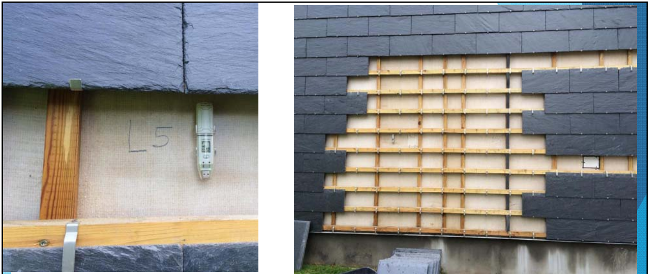
Registrering af fugtforholdende omkring facader
