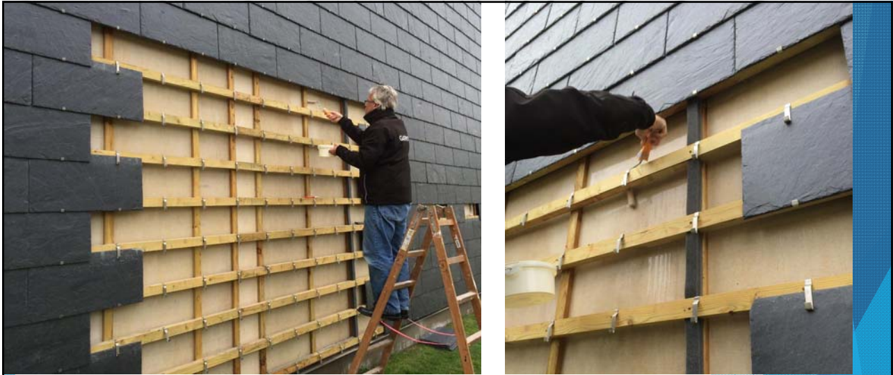
Forsøg med overfladebehandling af vindspærreplader
