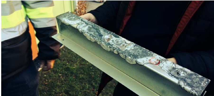
Facadebeklædnings ophæng korroderet.
