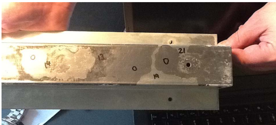
Forzinkningen er stort set væk.
