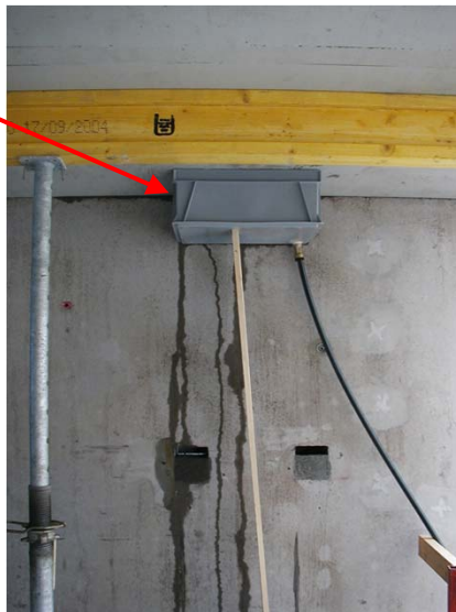
Kärl med avvattningsslang under ursparing i översta betongbjälklaget
